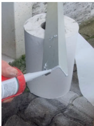
11 An der Rückseite der Niete und dem Rand, der auf dem Boden aufsteht, mit Silikon abdichten.
