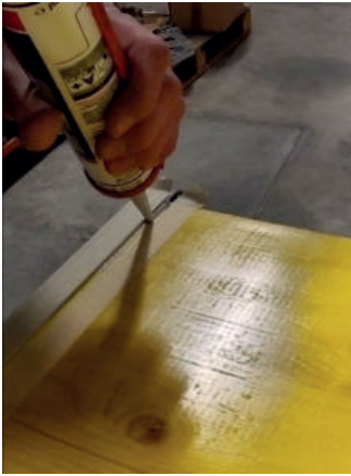
16 Eine Silikonnaht in die Ecke zwischen dem Seitenwinkel und der Schalttafel auf der Seite gegenüber der Dichtung auftragen.
