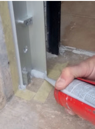
19 Eine Silikonraupe am Fuß des Eckwinkels setzen
