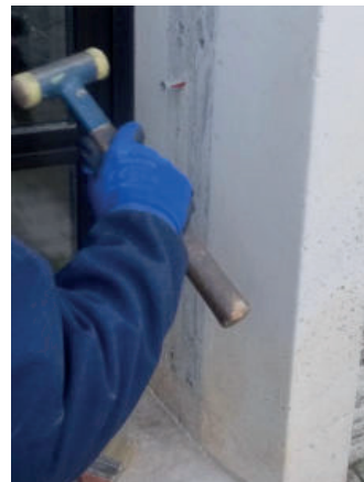
9 Die Dübel einsetzen.
