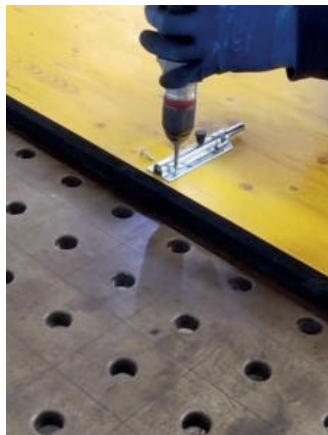
31 Montieren Sie an der markierten Stelle den Schubriegel.
