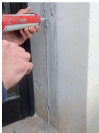
10 Im Bereich der Montagefläche Silikon auftragen
