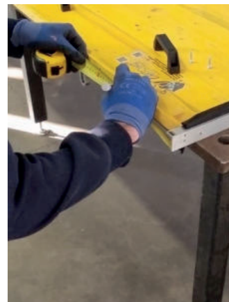
32 Die Positionen der Griffe jeweils 200 mm von der Außenkante markieren.
