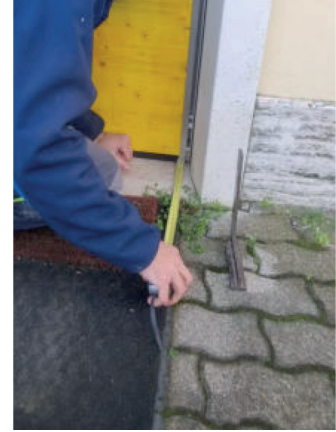
3 Die Wasserschutzwand in der gewünschten Lage positionieren.
