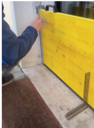
5 Die Position der Eckwinkel markieren.
