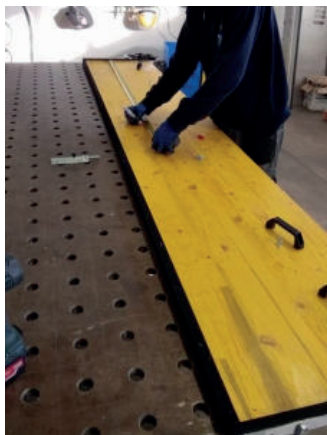
30 Messen Sie unten die Mitte der Wasserschutzwand.
