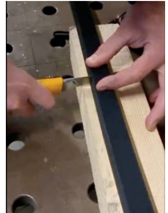
21 Die Dichtung mit einem Cutter und neuen Klingen vorsichtig im Winkel von 90° zuschneiden.
