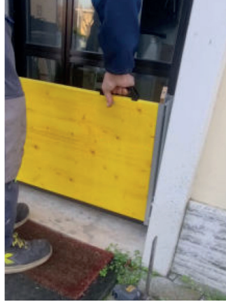
2 Die Wasserschutzwand in die Öffnung einsetzen.
