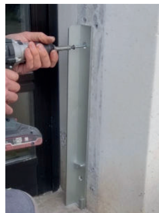
13 Die Eckwinkel an der Wand anschrauben.
