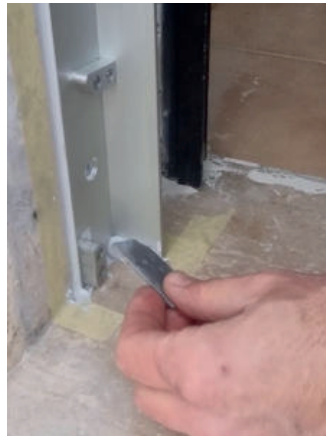
20 Die Silikonraupe mit dem mitgeliefer- ten Plättchen verteilen (die abge- schrägte Seite verwenden).
