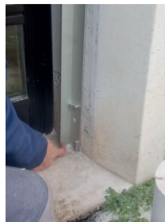
14 Das überschüssige Silikon entfernen.
