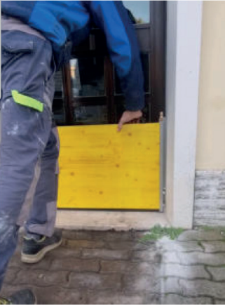
16 Die Montageposition der Wasserschutzwand prüfen.
